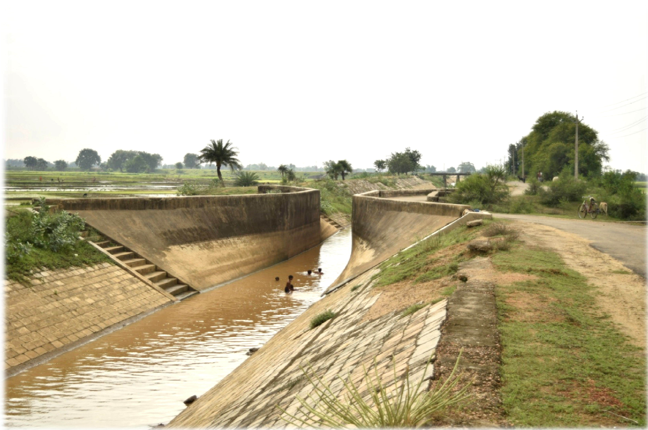
RD 74.21 L.D SYPHON OVER LOCAL NALLA
