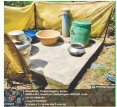
कार्यात्मक घरेलू नल कनेक्शन का निरीक्षण
