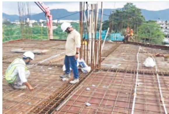
ऑडिटोरियम कॉलम शटरिंग और स्टील टाईइंग का कार्य प्रगति पर
