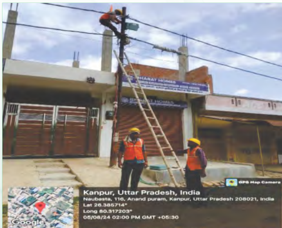
खुले कंडक्टर/क्षतिग्रस्त केबल को एबी केबल से बदलना
