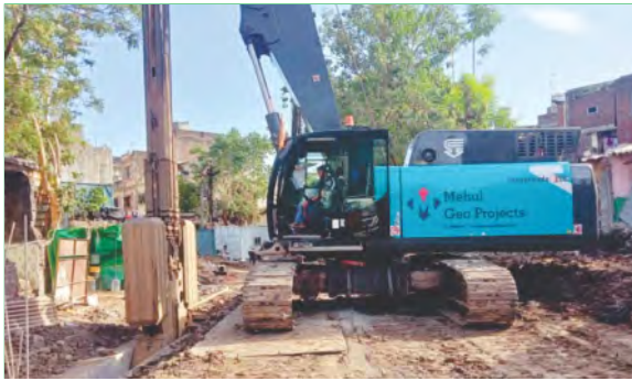
डायाफ्राम वॉल की खुदाई का कार्य प्रगति पर
