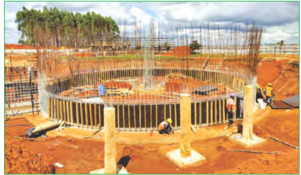
क्लेरिफ्लोक्यूलेटर बी बाहरी दीवार में शटरिंग का कार्य-जोम्बे डब्ल्यूटीपी
