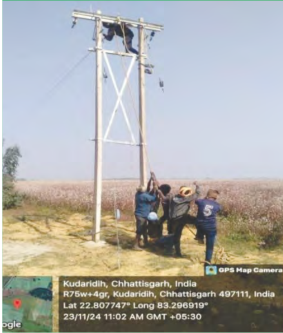
डबल पोल निर्माण कार्य (11 केवी लाइन)
