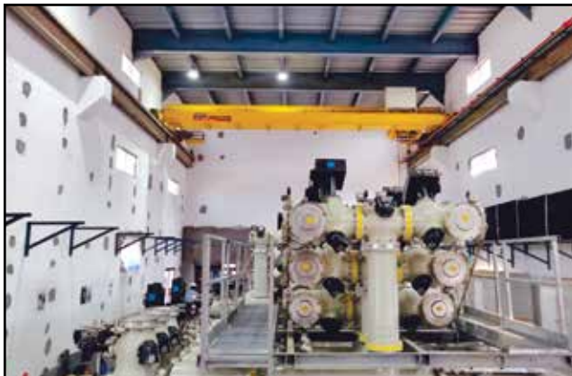
220 KV GIS Switchgear
